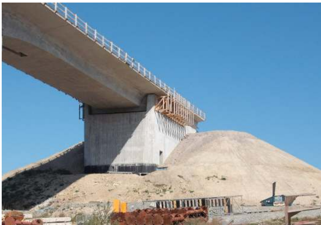
Abbildung 20: Fertiggestelltes Brückenwiderlager der Achse 13 mit Anschlussdamm, Stand: September 2009
