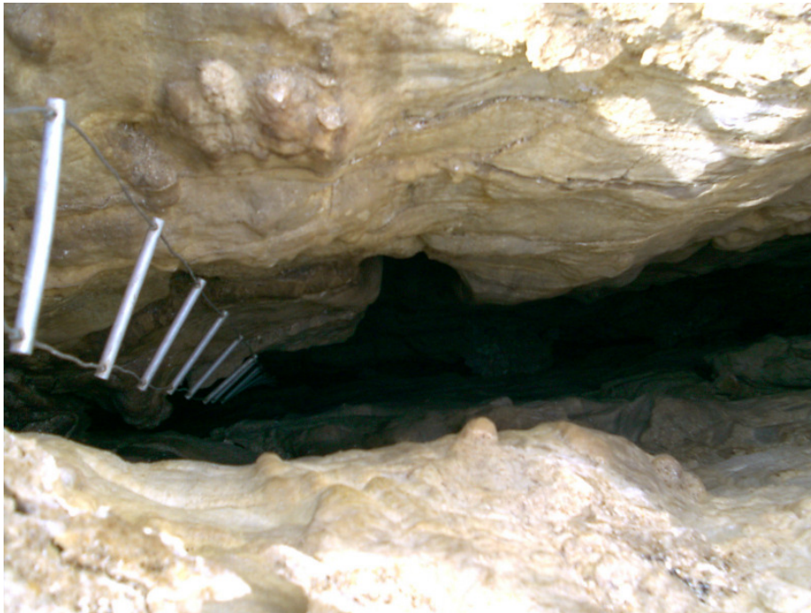
Bild 2: Karstspalte im Einschnitt E5 des Planfeststellungsabschnittes 62
