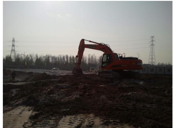
Bild 10: Mischvorgang mittels Bagger mit Tieföffel
