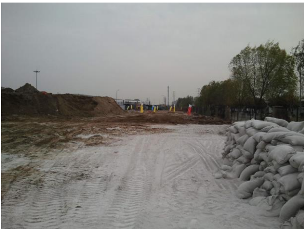
Bild 9: Ausbreitung von Bindemitteln auf einer Schüttlage
